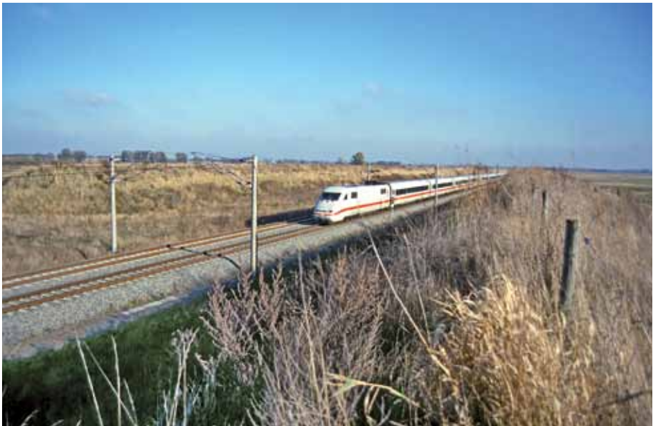
Abb. 6: ICE-Strecke Berlin Hannover im Zentrum des Großtrappeneinstandsgebietes Havelländisches Luch. Schutzwälle verhindern Anflugopfer an den Bahnstromleitungen und sorgen im NSG für ausreichenden Sicht- und Lärmschutz. Foto: Heinz Litzbarski
